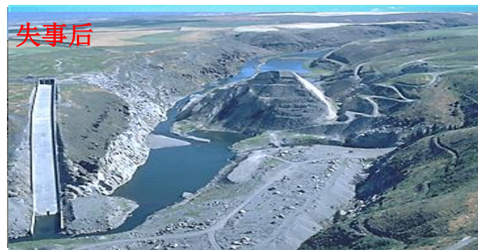
失事后 美国Teton土坝因渗透破坏导致溃决
